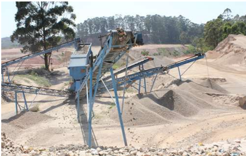
Figura 18: Usina de Reciclagem de Entulhos
