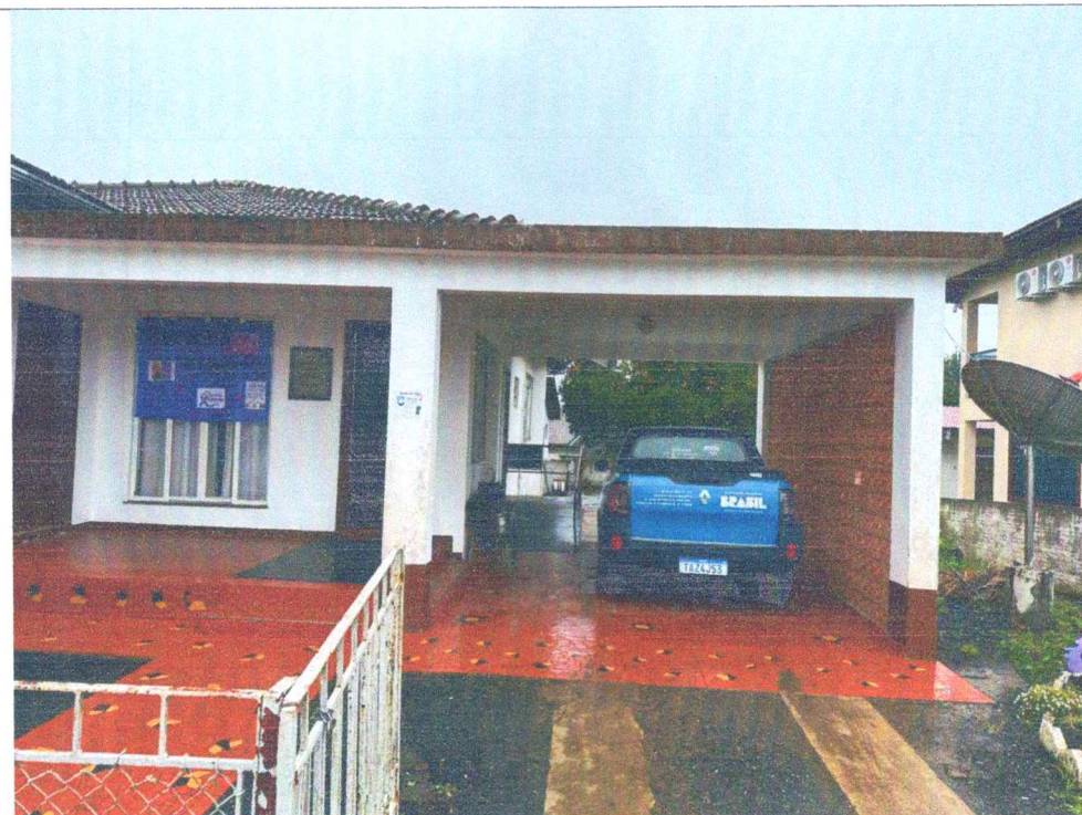
03 – Fachada, vista frontal
