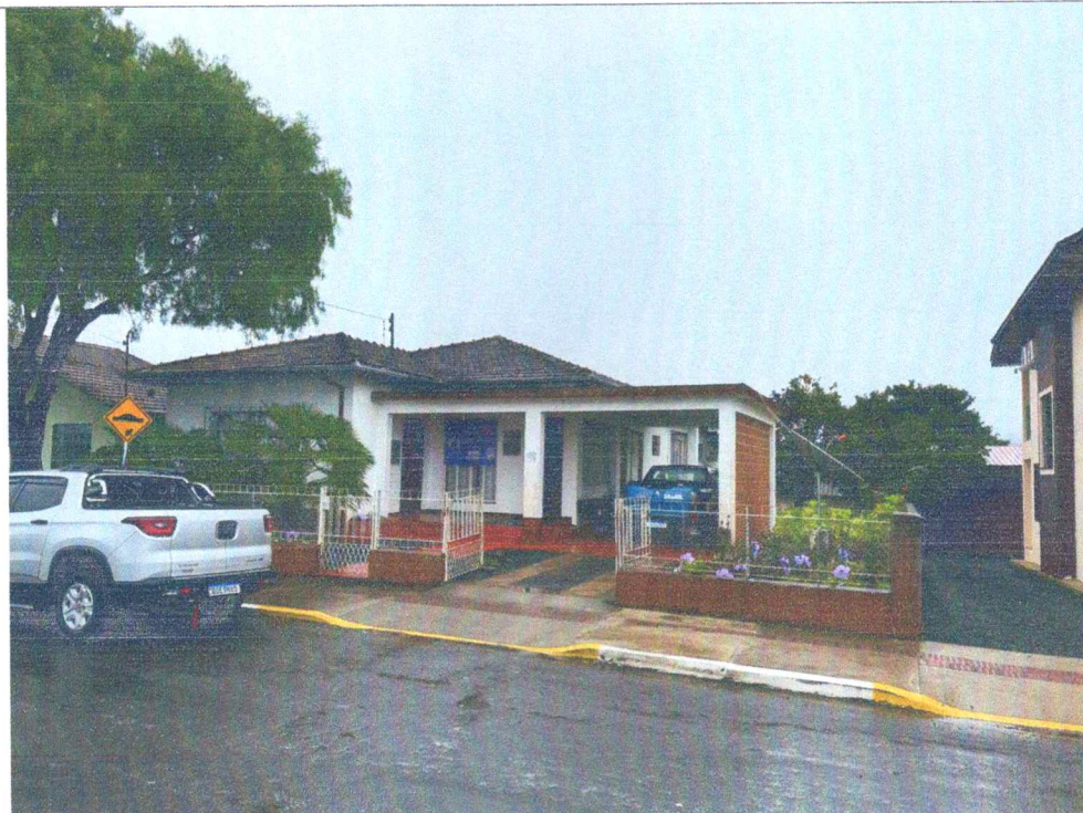
05 – Fachada, vista frontal
