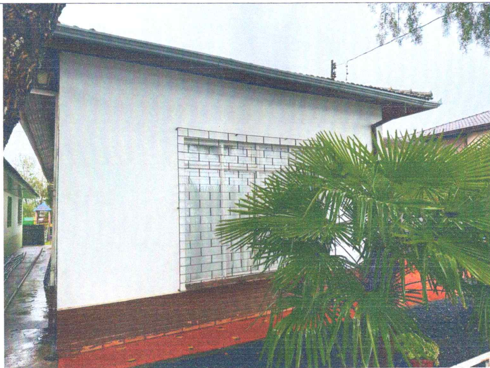
01 – Fachada, lado esquerdo
