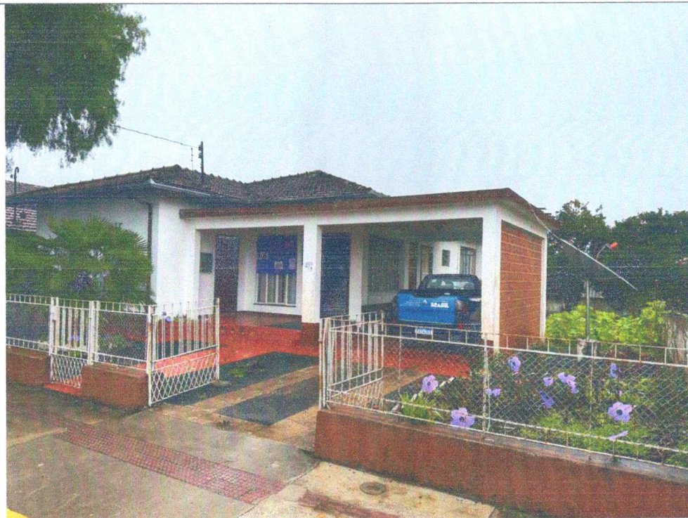
04 – Fachada, vista frontal
