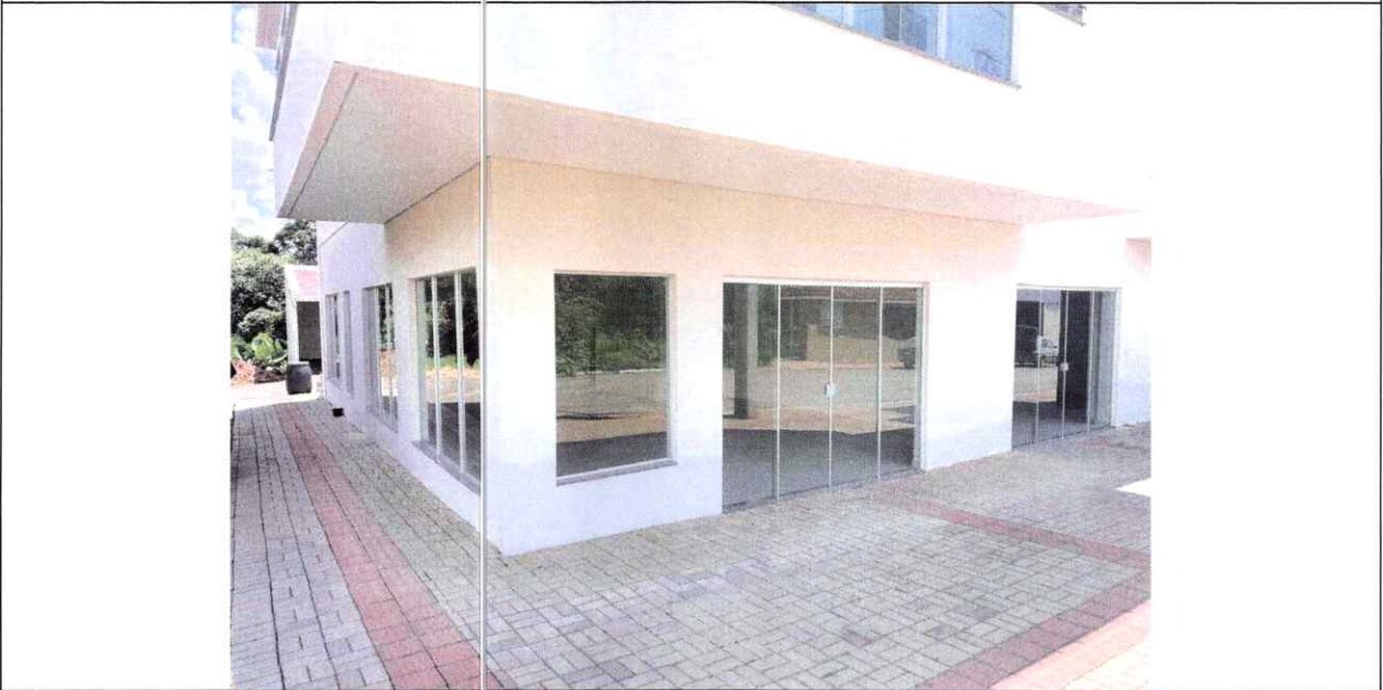
Foto 02 – fachada, vista sala 01 e 02
