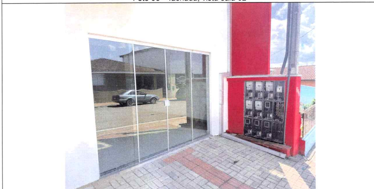
Foto 04 – fachada, vista sala 03
