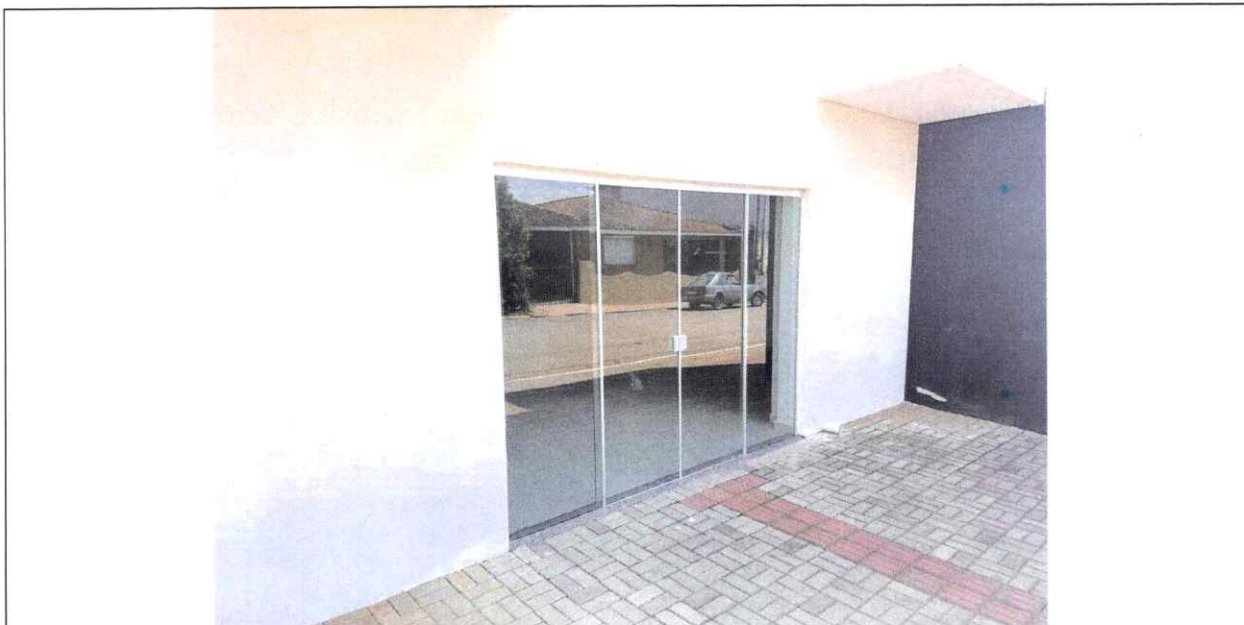
Foto 03 – fachada, vista sala 02
