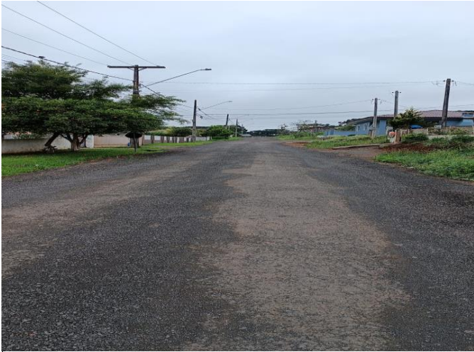
TRECHO 05: RUA ARISTO RAZERA, entre a rua Alexandre Popia e a rua Antonio Zalonc.
