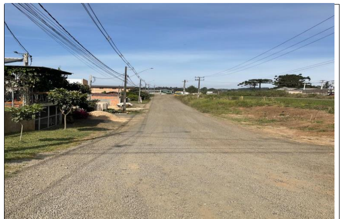
TRECHO 02: RUA HALIA RETCHESKI POPIA, entre a rua João Horzyn e o fim da rua.
