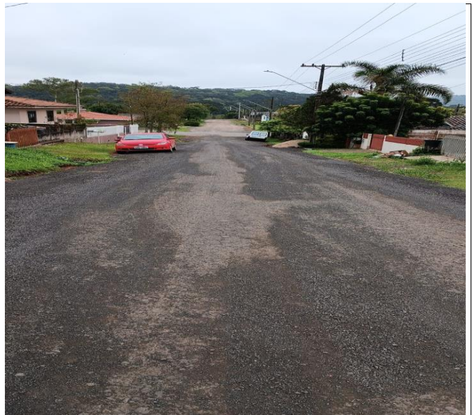
TRECHO 05: RUA ARISTO RAZERA, entre a rua Alexandre Popia e a rua Antonio Zalenc.
