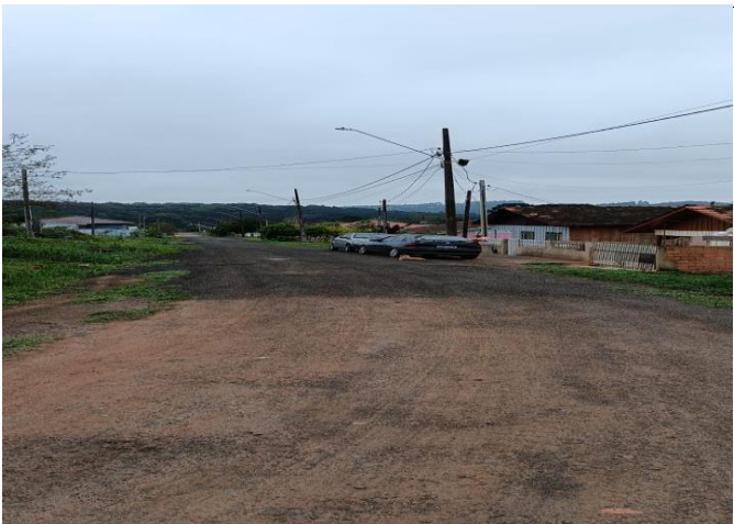
TRECHO 05: RUA ARISTO RAZERA, entre a rua Alexandre Popia e a rua Antonio Zalonc.
