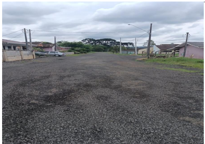
TRECHO 04: RUA JOÃO TREUCK, entre a rua Rui Barbosa e o fim da rua.
