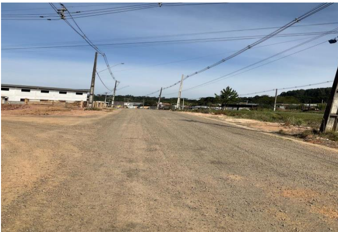
TRECHO 02: RUA HALIA RETCHESKI POPIA, entre a rua João Horzyn e o fim da rua.
