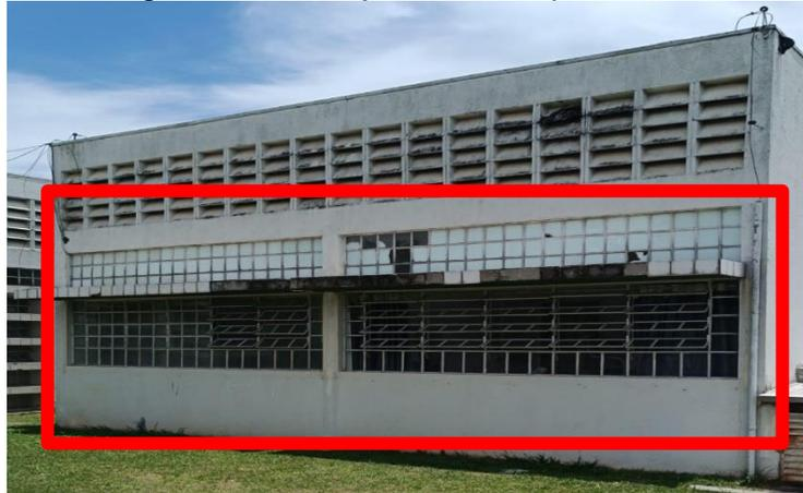
No local representado na Imagem 03, circulado por linha contínua vermelha será implantado uma janela do tipo J20. E circulado por traços vermelhos, será implantado uma janela do tipo J17. (detalhadas no projeto de esquadrias em anexo).
